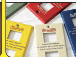
スイッチコンセントプレート交換
